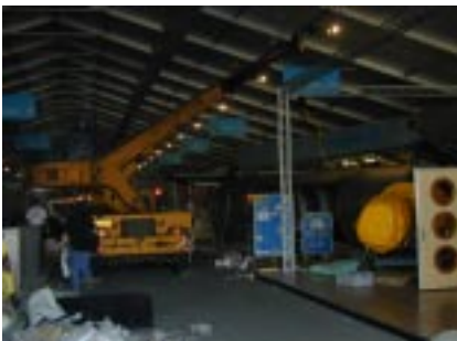
I Ericssons monter lyfts en Erieye-attrapp på plats
