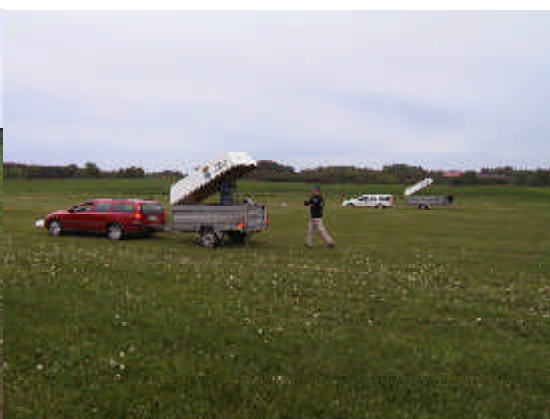
Utläggning av banbelysning. Det går fort om två bilar med släp används.
