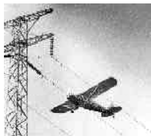
Kraftledningsinspektion i Östgötaflygs regi utfördes huvudsakligen av Arne Kjellström.
