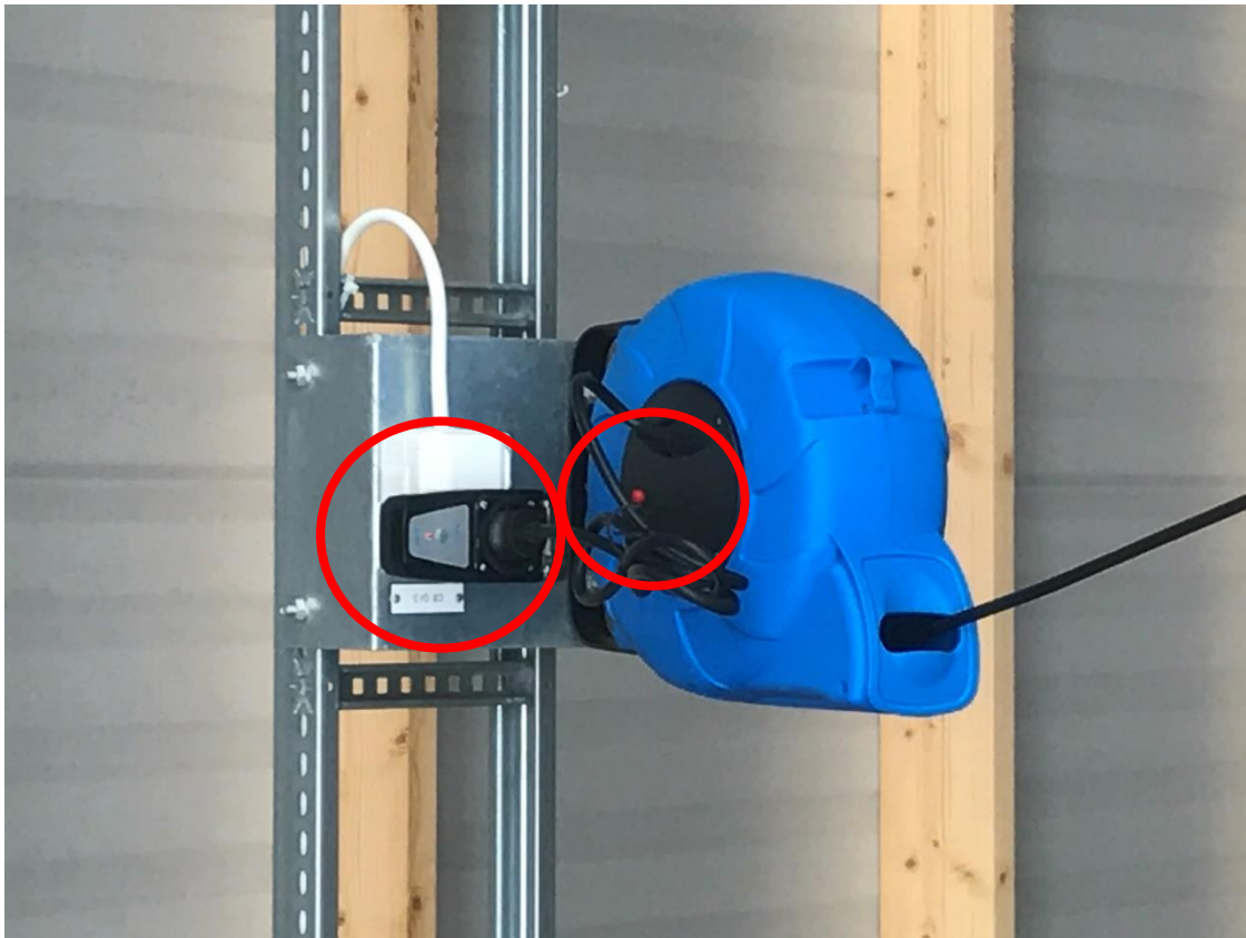
Fig. 4 – Uttag för motorvärmare i taket med fjärrkontroll
